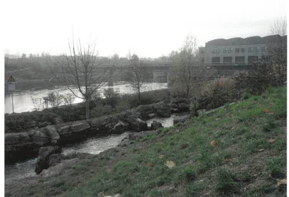
Abb. 6: Renaturierungsmaßnahmen und Fischtreppe beim Kraftwerk Ruppoldingen Quelle: Alpiq Hydro Aare AG
