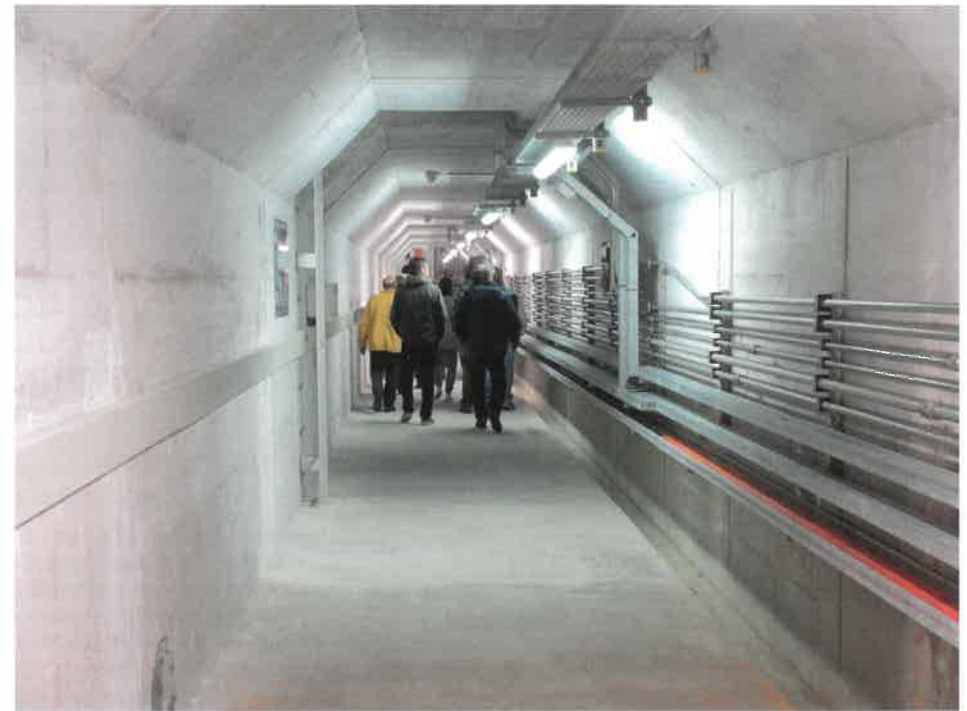
Abb. 7: Gang durchs Wehr im Kraftwerk Ruppoldingen
